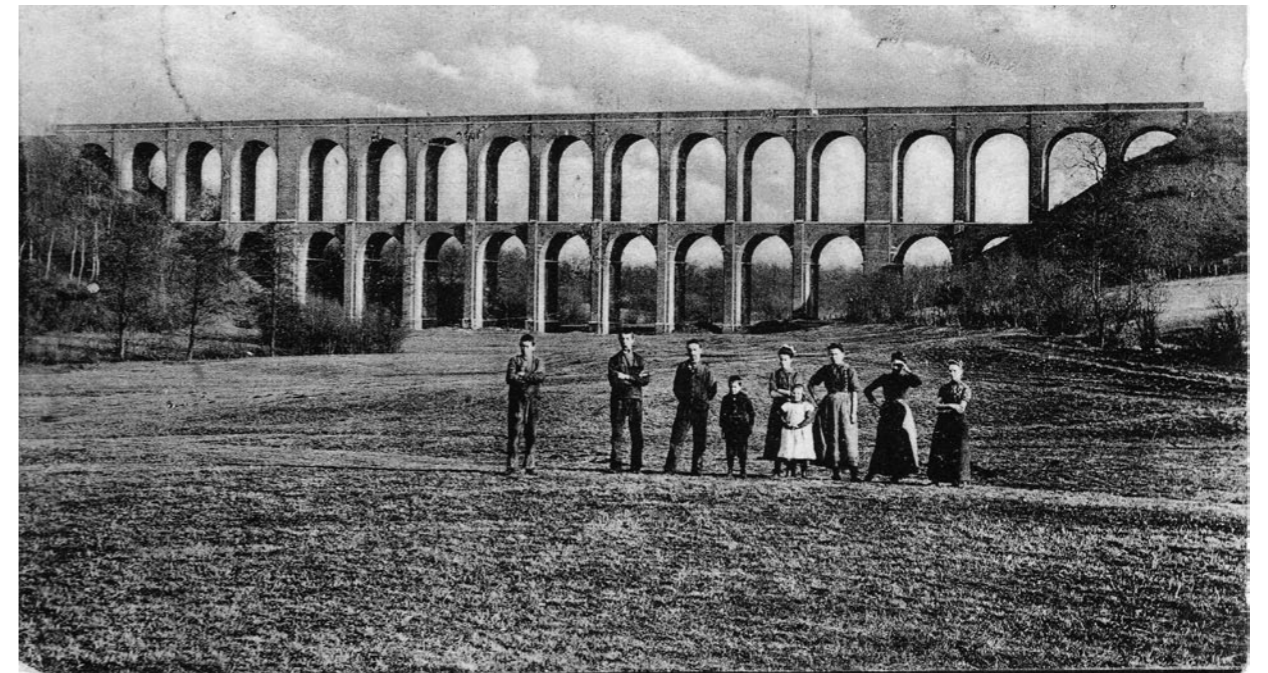
Der Geulviaduct „Hammerbrücke“ überspannt das Göhlthal an der Grenze von Hauset zu Hergenrath
