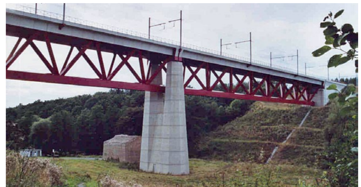
Die neue Brücke wurde gebaut um auch Fahrten des Hochgeschwindigkeitszuges zu ermöglichen. Sie wurde von 1997-1999 errichtet. Richtung Lüttich teilt sich kurz hinter der Brücke die Trasse, so dass eine zweite Brücke über das Tal der Mulde gebaut werden musste.
