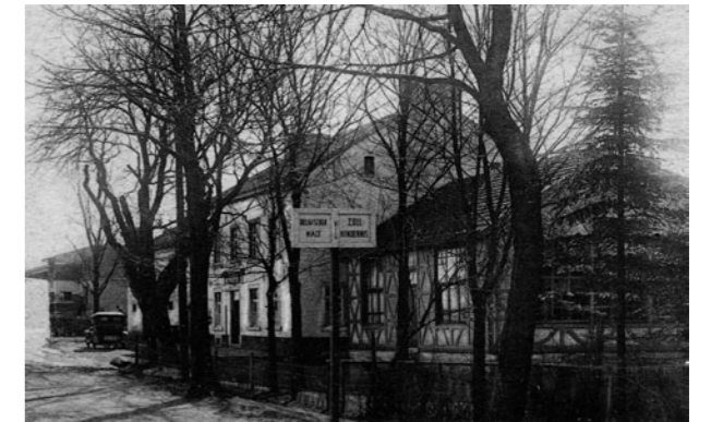
Ansicht des Cafés von Aachen kommend.
