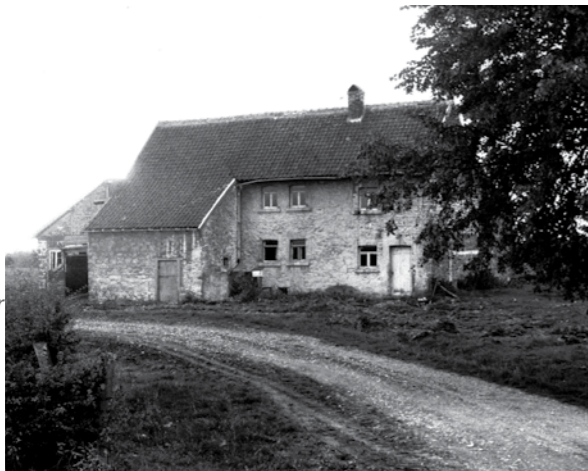
Hammerbrücke gefallen nach der g der Hammer-
